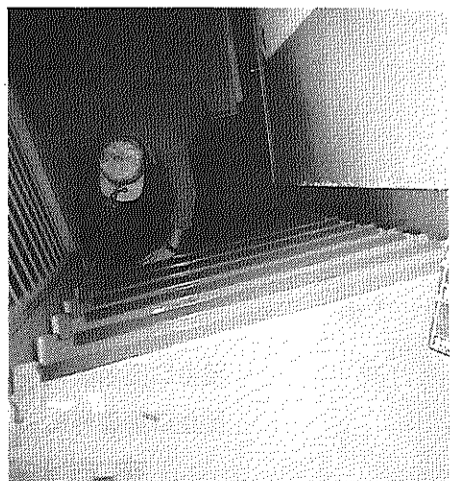
左、階段防水工事・右、階段スリップストップ付け
