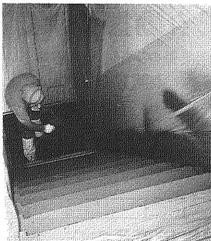
左、階段防水工事・右、階段スリップストップ付け
