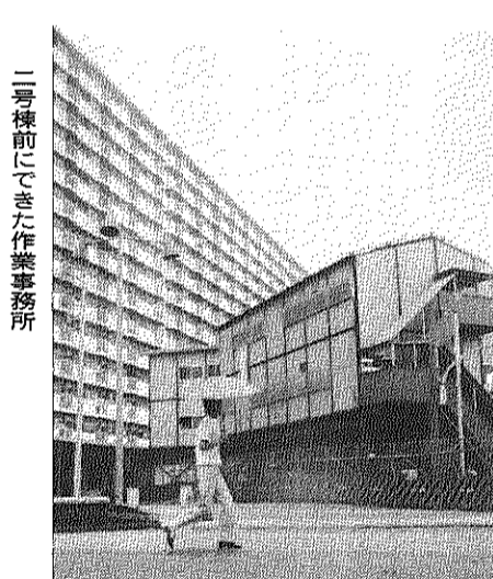
二号棟前にきた作業事務所
